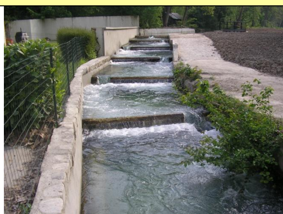
Exemple de passe à bassin successif sur la rivière Voulzie (77) : conception et MO CIAE (2007)
