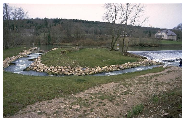
Exemple de passe à poisson dites « naturelles » : création d'un bras de contournement de l'ouvrage sur la Loue
