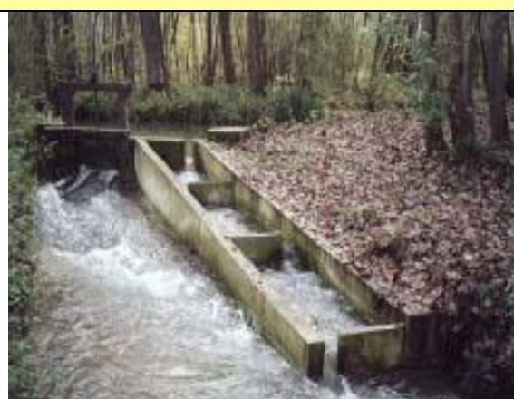
Passe à échancrures latérales et orifice noyé (toutes espèces) en béton ferrailé brut Vannage de Flagy, rivière Orvanne (77) : conception et MO CIAE
